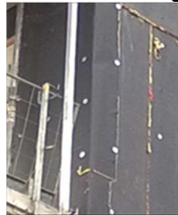
Välisnurk kaetud TW57-laminaadiga
