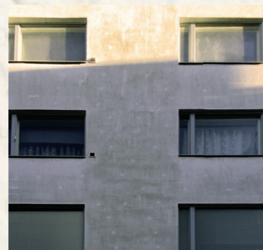
Tavaliselt hakkavad "roheliste" fassaadide peal silma valged täpid - need on tüüblipead, mis toasoojusega kiiremini üles soojenevad ning seeläbi krohvi selle koha pealt kiiremini ära kuivatavad
