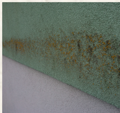
Fassaadid võivad soodsates tingimustes kergesti kattuda samblikuga
