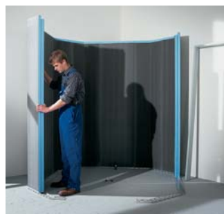
Paigaldamine metallist karkassile soone ja sideliistu süsteemil
