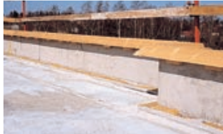
1. Parapetiitööd enne kergkruusa paigaldamist.
