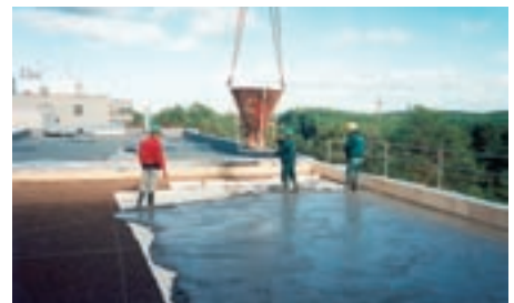
4. Tasandatud kergkruusale valatakse õhuke 30...40 mm paksune tasandussegu kiht (nt. weber S30 -ga).
