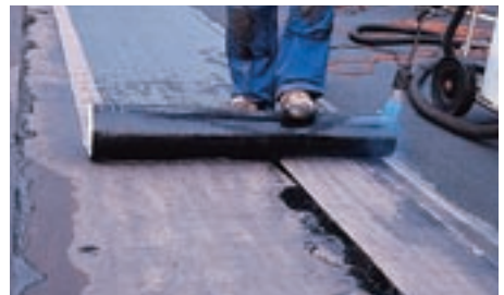
6. Bituumen rullmaterjal kleebitakse tasandusvalu või plaatide peale.
