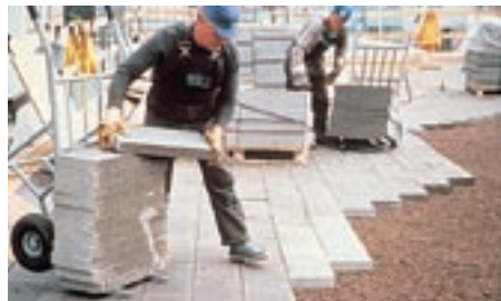
5. Väi laotakse (kerg)betoonplaadid.
