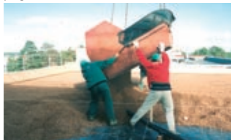
3. Kergkruus tõstetakse katusele tõstekastiga ning tasandatakse.
