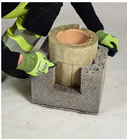
Paigaldatakse šamott-toru ja vill. Villale kantakse mõõdetud ja lõigatakse villale vajalik ava.
