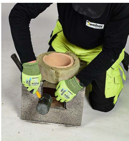
Paigaldatakse šamott-toru ja vill. Tehtud avasse sobitatakse metallist hülss.
