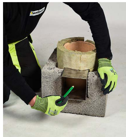
Kasutades tahmaluugi metallhülssi, kantakse mõõdetud šamott-torule.
