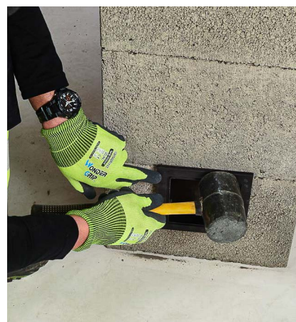
Paigaldatakse järgmine mantelplokk ja veendutakse, et hülss sobitub korrektselt kohale.
