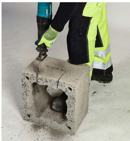
Mantelplokki lõigatakse mõõdetud ava.
