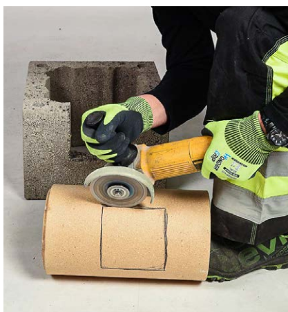
Ketaslõikuriga lõigatakse šamott-torusse sobiv ava.
