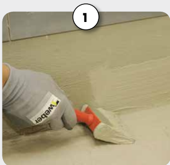
1 Veetõkke paigaldamine kiudkanga alla
