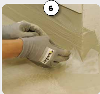
6 Välisnurga teise lapi paigaldamine
