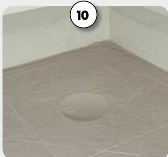
10 Korralikult hüdroisoleeritud trapp
