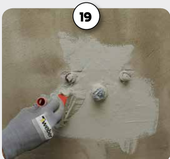
Läbiviigu tüki isoleerimine
