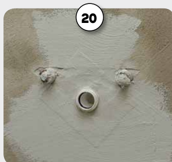
Korralikult isoleeritud läbiviik
