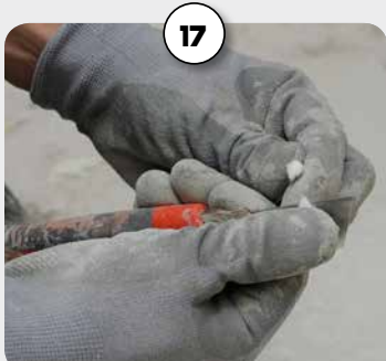
Läbiviikudele paraja suurusega armeerimislapi lõikamine
