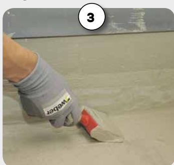
3 Peale kanga paigaldamist kantakse selle peale värsket kihti veetõkkemassi
