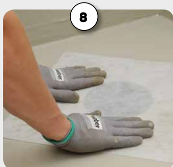
8 Esimese trapikanga paigaldamine
