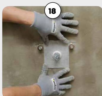
Läbiviigu tüki paigaldamine
