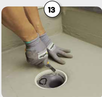
Pingutusrõnga paigaldamine
