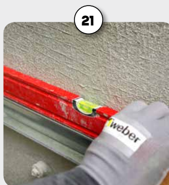
21 Plaadistuse alumise serva loodimine
