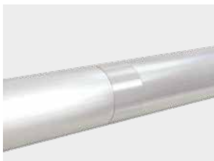
10. Painutage ja liimige kleplindi pikem ots torukooriku rõngale.
