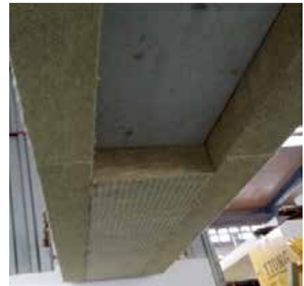
Tulekaitse tala põhjapinnal.
