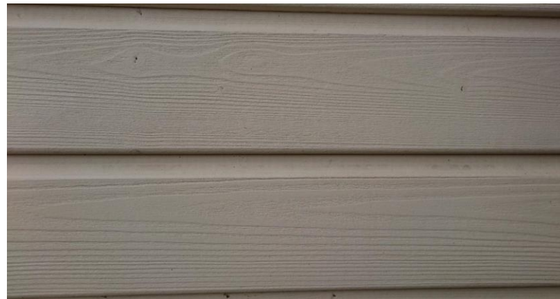
Termotöödeldud kuusk, paigaldatud 2009. Foto 21.6.2018 läänekülg
