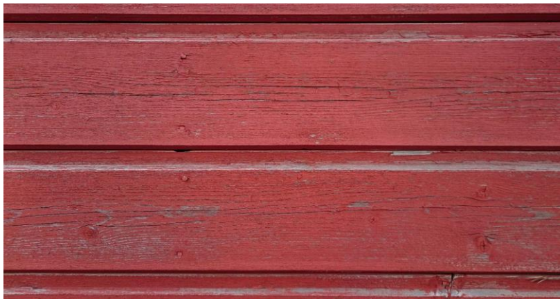
Naturaalne kuuse vooder, paigaldatud 2009. Foto 21.6.2018 läänekülg
