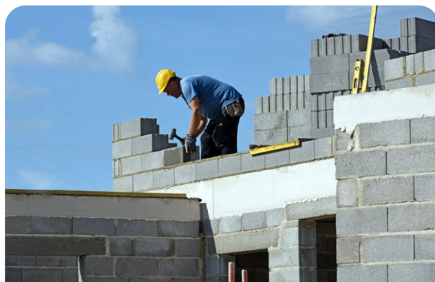
Ladumise käigus tuleb ploki otstes olevad tapid ja sooned korralikult kokku suruda.
