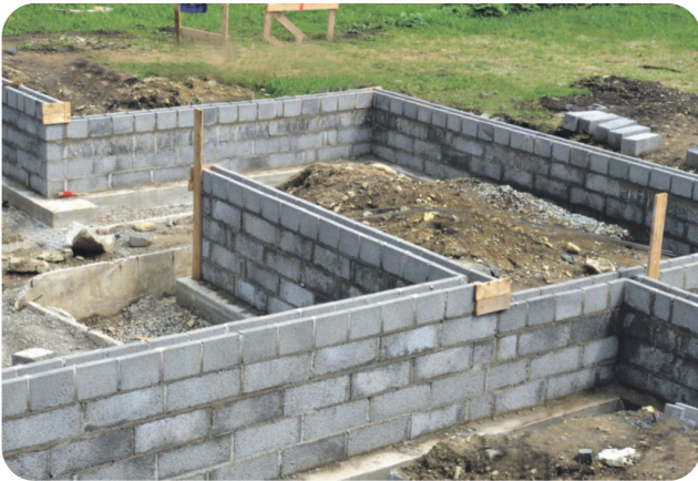
Fiboplokkid on niiskus- ja külmakindlad ning sobivad maja ehitamiseks vundamenditaldmiku räästani.
