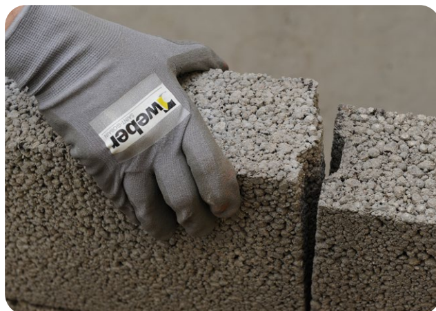
Ladumise käigus tuleb ploki otstes olevad tapid ja sooned korralikult kokku suruda.
