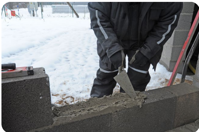
Müüritööd saab teha ka talvistes oludes minimaalselt -10^{\circ}\text{C} temperatuuriga.
