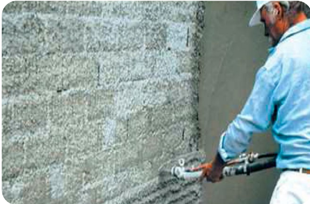
weber TT on tugev ning niiskuskindel täitepahtel kiviseinte esmaseks tasandamiseks.
