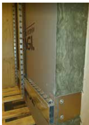
Joonis 10. SerpoVent U seinakandurid A-B ning SerpoVent profilid OL-33 soojustusele ja CLT-plaadile paigaldatuna
