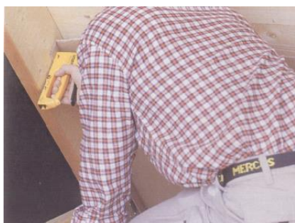
ISOVER tuulesuunaja paigaldus klambripüstoliga
