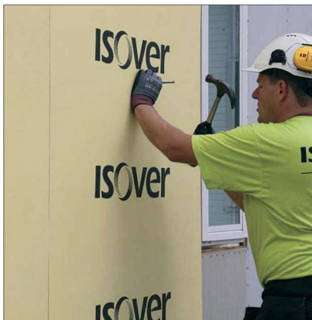
Kinnita plaat läbi kinniti keskel oleva augu naelaga.
