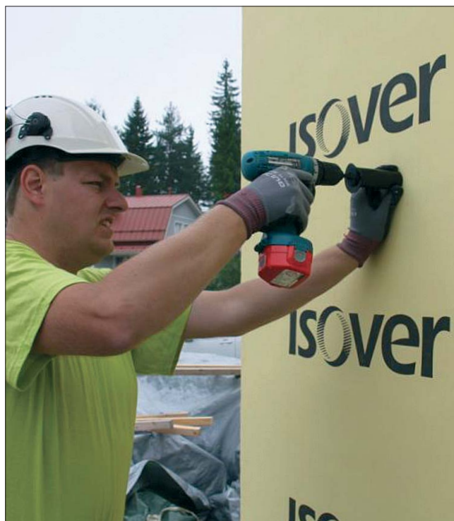
Keera/puuri TermoFix kinniti läbi plaadi kasutades selleks spetsiaalset otsikut.
