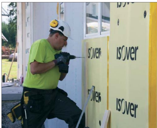
Tuulutusliistude kinnitamine / seina loodimine.
